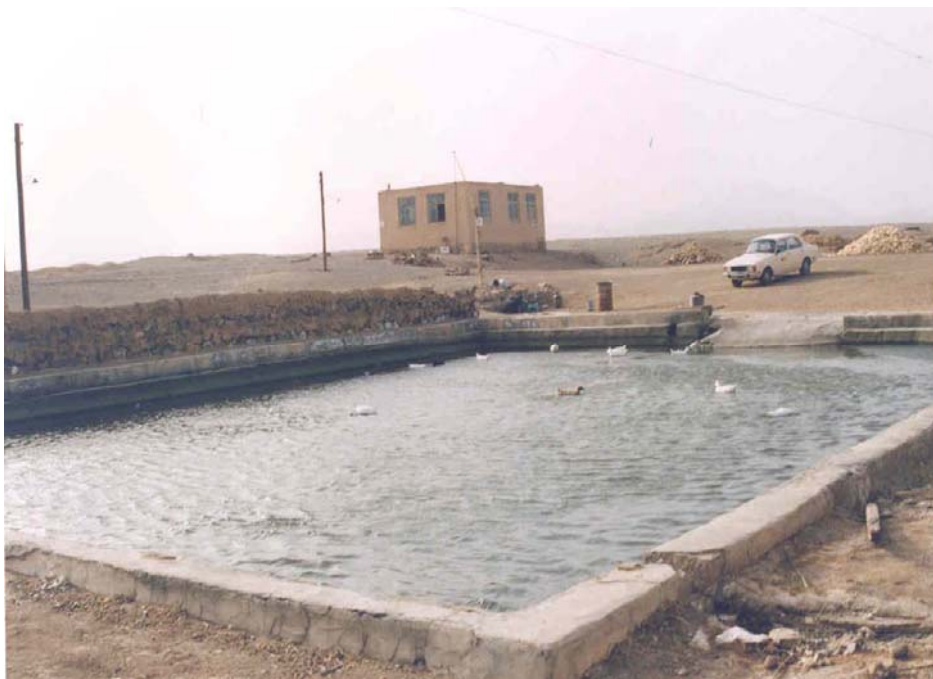
تصویر شماره ۶: استخر جدید ذخیره آب قنات اریکا
