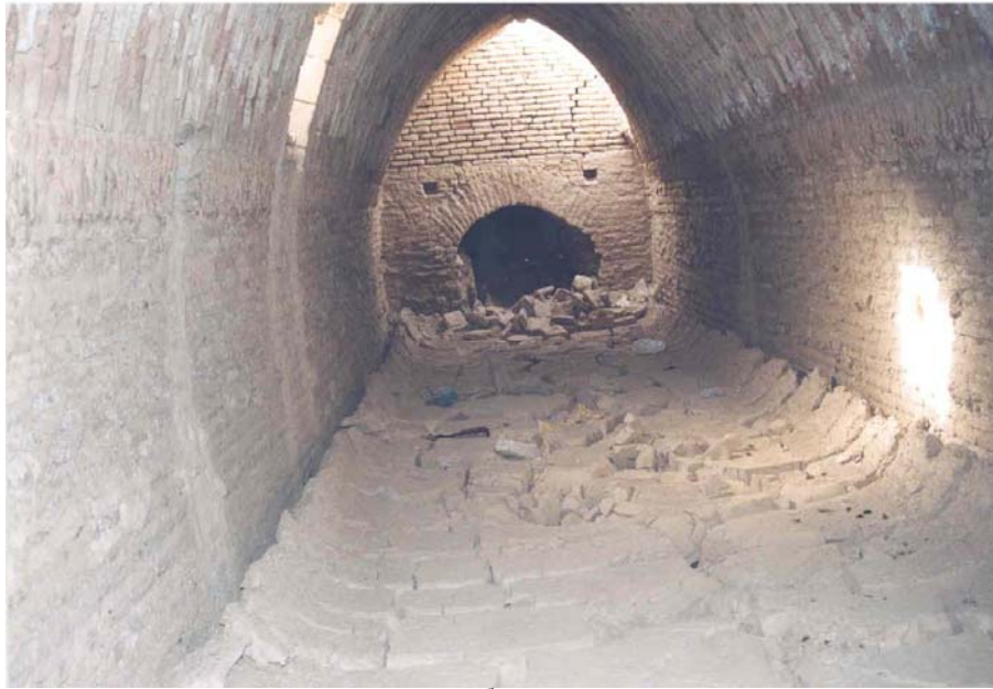
تصویر شماره ۸: یکی از دو مخزن آب انبار نوگنبد به شکل مستطیل که امروزه انباشته در گل و لای است.
